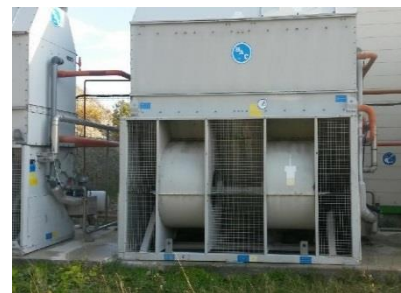
Intervention chez Bonduelle traiteur à Saint Benoit sur vannes
